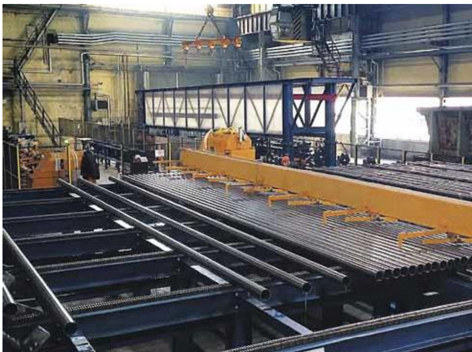
РИС. 4. Оборудование для снятия фаски и гидроиспытания труб
